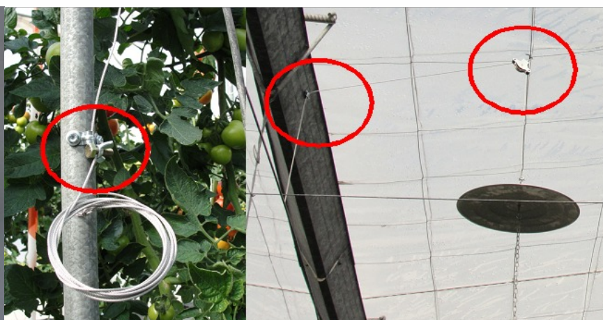
Imagen 6: Instalación del sublimador (sistema de elevación)
