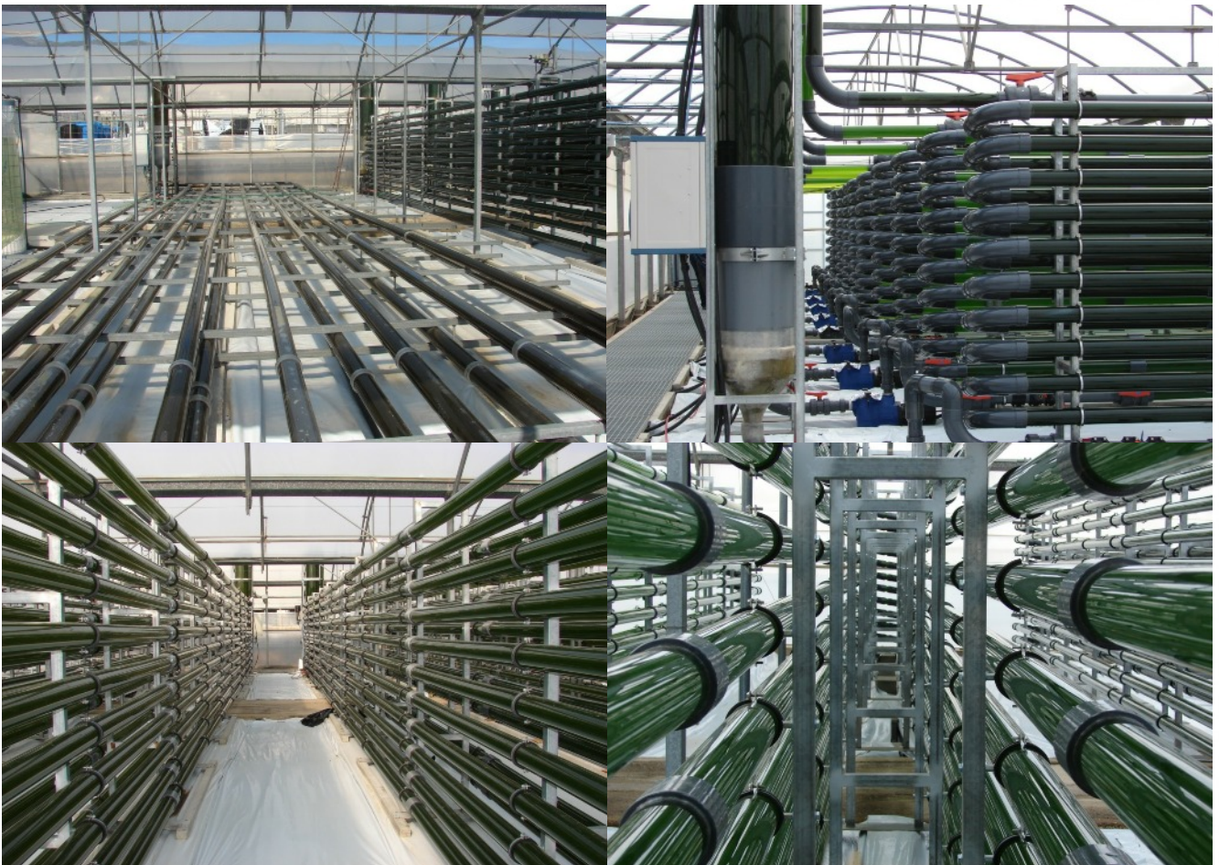
Imagen 9. Fotobiorreactores tubulares: horizontal (A) configuración vertical, (B y C) y detalle de la estructura del fotobiorreactor (C), localizado en la Estación Experimental de Cajamar.
