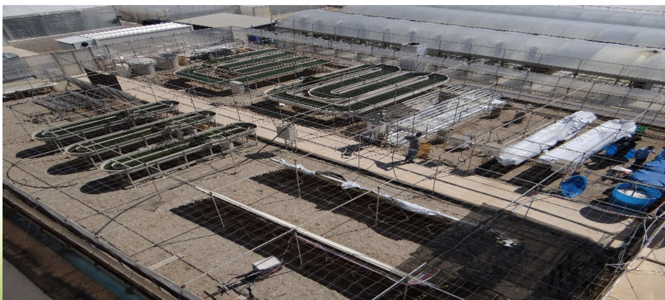
Imagen 1. Vista general de las instalaciones en la Estación Experimental de Cajamar
