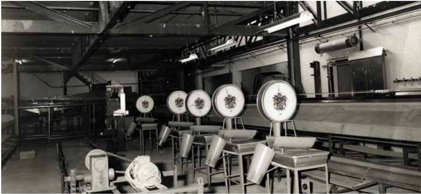
La instantánea recoge la maquinaria y las básculas para el pesaje y calibrado de las naranjas.
