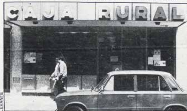
Antigua sede de la Caja Rural de Torrent.
